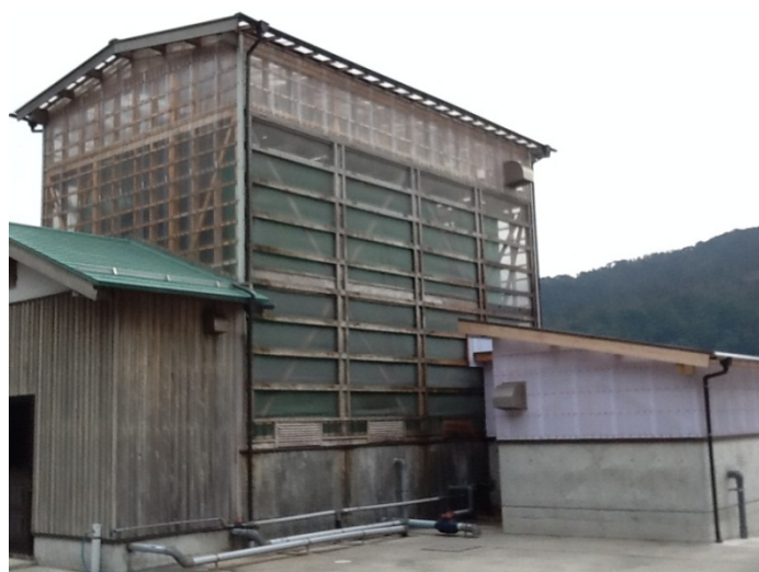
写真6 濃縮濾過棟：塩乾燥の薪が用意される。(筆者撮影)
