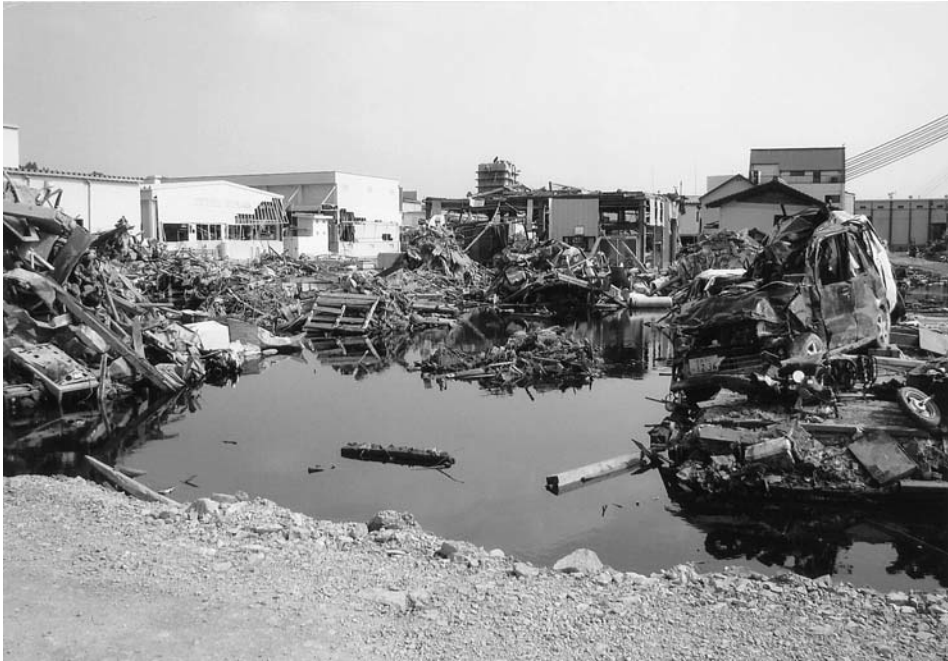
図2 宮城県気仙沼市川口町。気仙沼湾内の漁港の町，地盤沈下により海水が浸入している。 手前の道路は震災後に埋めて高くした。
