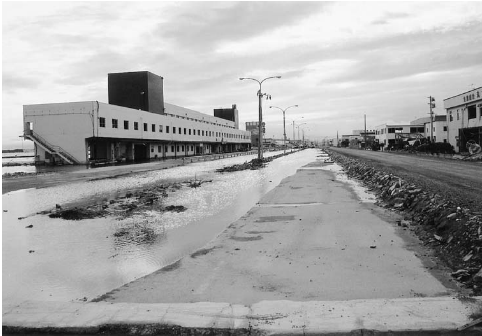
図6 宮城県石巻市魚町。道路の地盤沈下により冠水している。この水面は建物の左側にある海面と同じ高さである。
