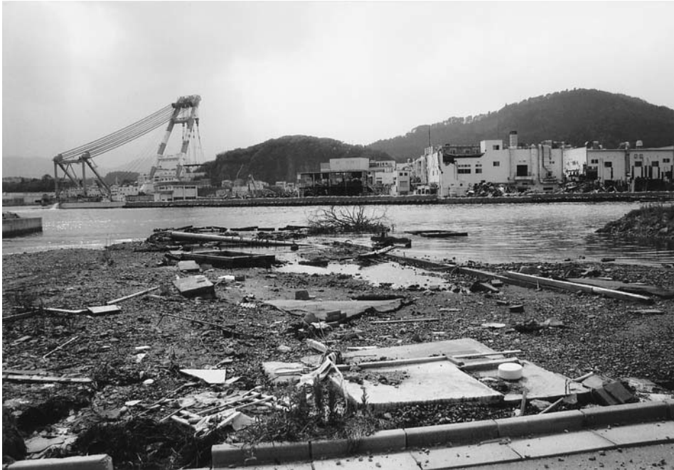
図1 宮城県気仙沼市気仙沼漁港の対岸。海岸は液状化により沈下し、海水が浸入している。
