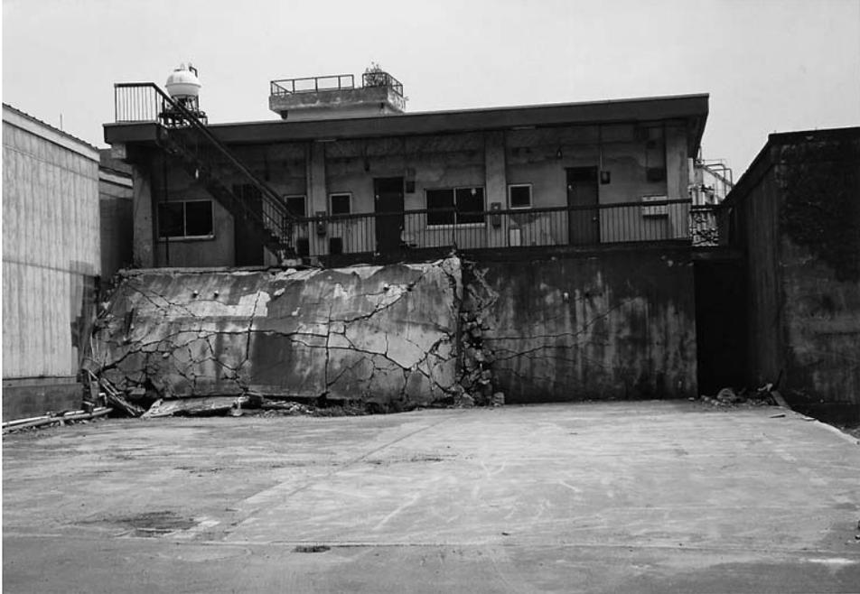
図18 津波の水圧によりコンクリートの壁が押し出された。釜石市街地。
