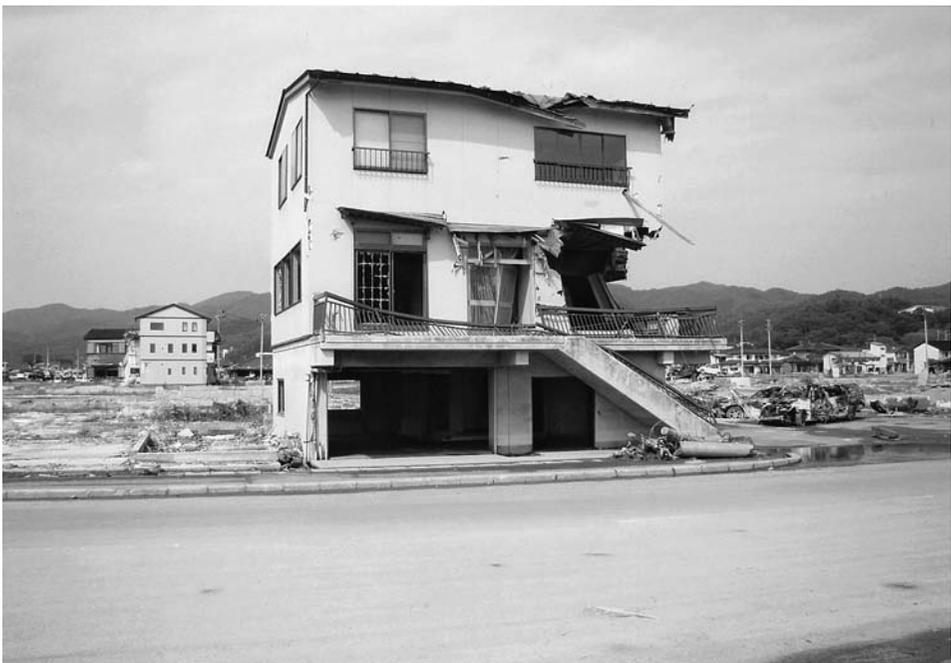
図2 津波被害を受けた三階建て住宅。気仙沼漁港。
