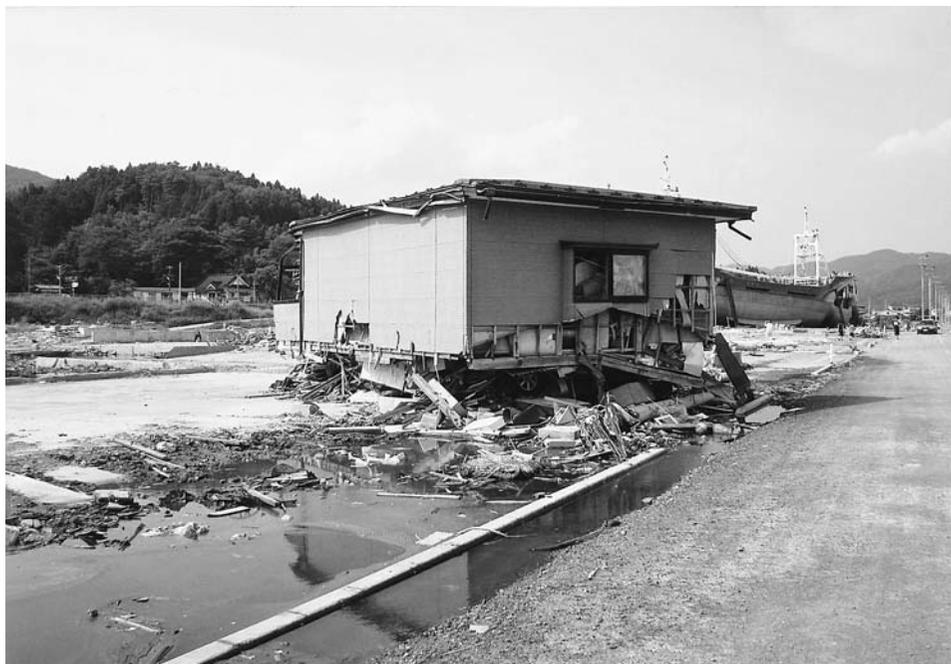
図3 浮遊して移動した二階部分(?)。気仙沼漁港。
