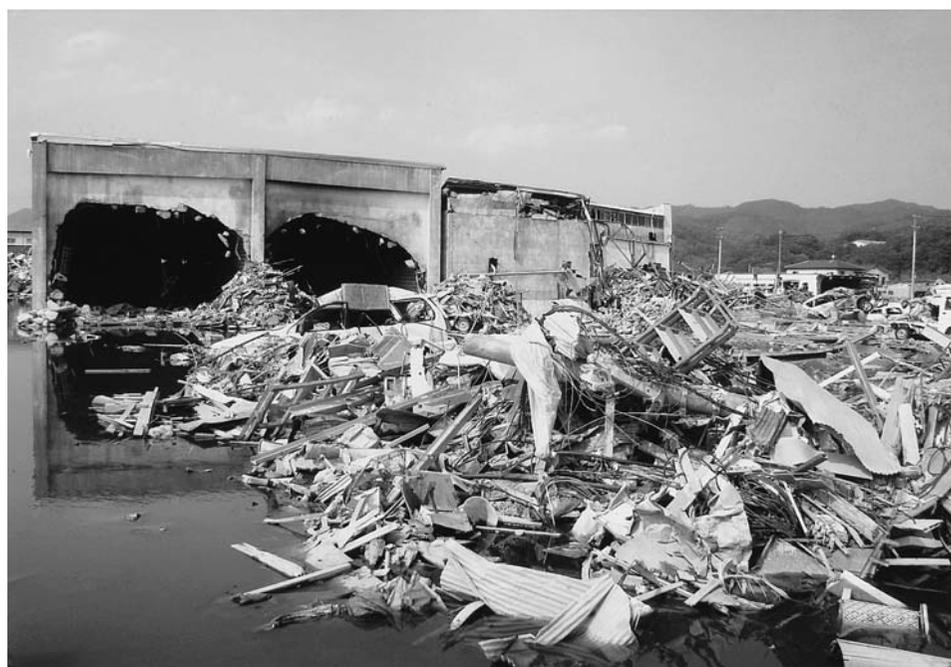
図4 津波の直撃により大穴の開いた倉庫の壁。気仙沼漁港。
