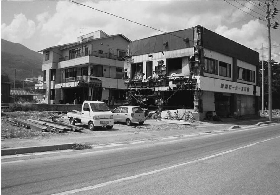
図16 内陸の住宅で二階部分に津波被害を受けた。宮城県大船渡。
