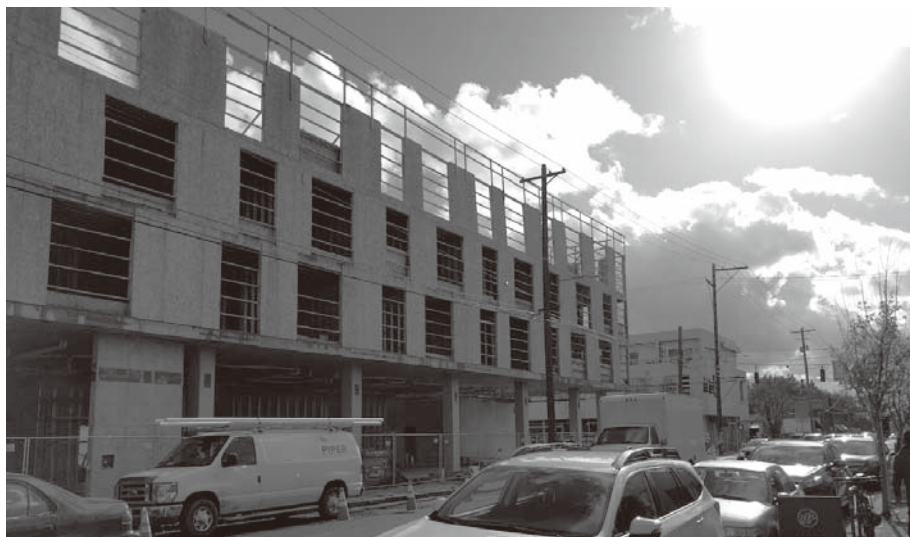
図10 ボイジーで建設中のコンドミニアム
