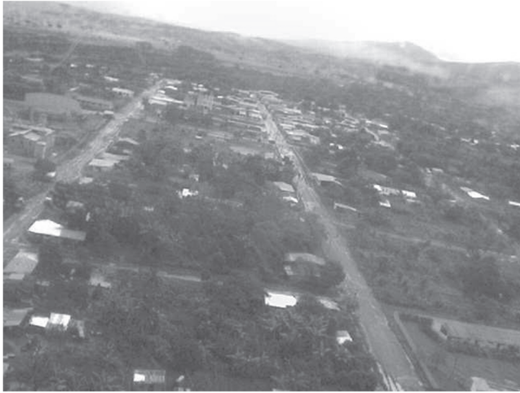
図3 マカレナ村（2010）。整然と区画された街路はすでに1970年代は出来ていた。
