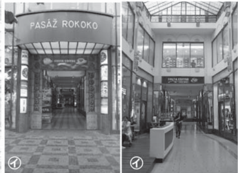
写真54 パサージュ・ロココ L字型通路 通路の一部にカフェテラスを設置
